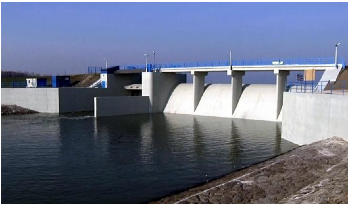
Bezpečnostný priepad po rekonštrukcii
