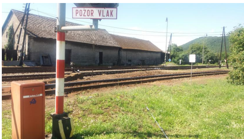
Obr.27 Časť železnice, kde došlo ku havárii
