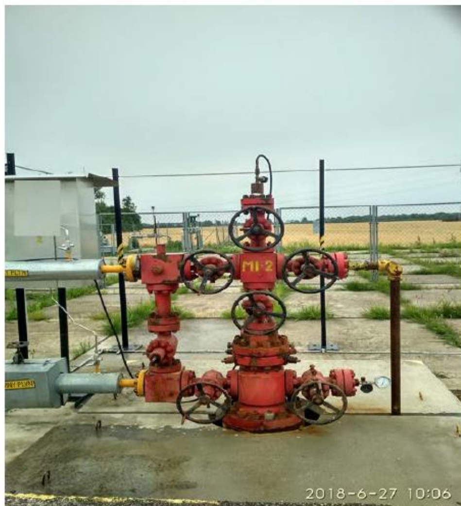
Obr. 7. Produkčný kríž zlikvidovanej plynovej sondy s kamerovým systémom (foto archív autora).
