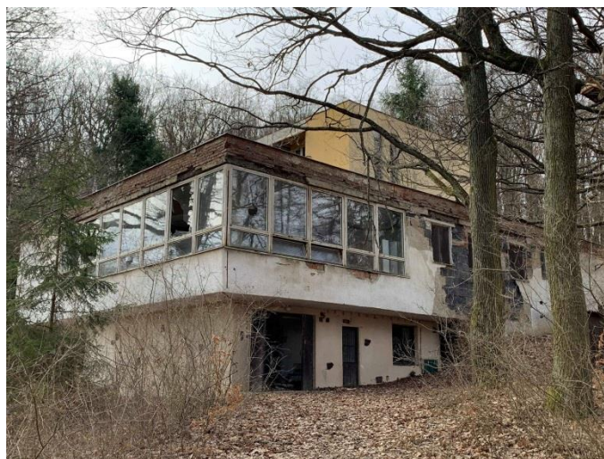
Obr. 7 Nefunkčné kúpele Byšta
