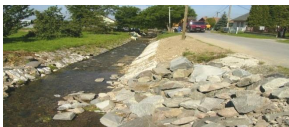
Obr. 4 Vyšná Šebastová – zabezpečovacie práce
