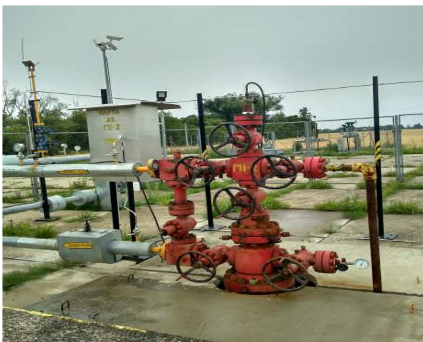
Obr. 3 Vystrojenie plynovej sondy s kamerovým systémom a s oplatením sondy (archív autora)
