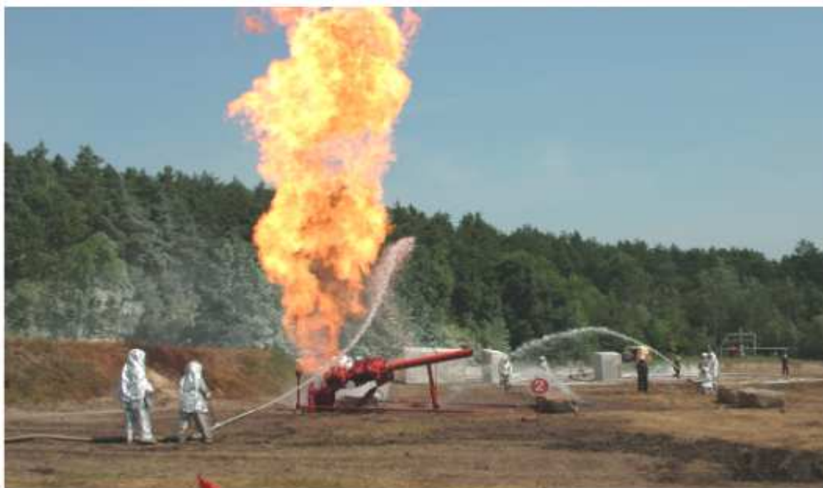
Obr. 2. Inštalácia protierupčného zariadenia (v angl. Blowout Preventer - BOP) na ústí vrtu. [3]
