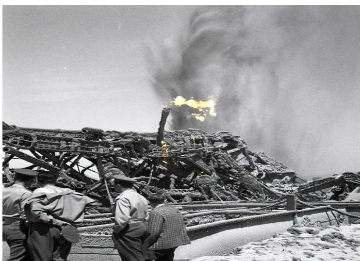
Obr. 6 Erupcia a požiar zemného plynu na vrte Stretava 15. Horiaci gejzír chrlil bahno a žeravý piesok až do vzdialenosti 300 metrov od ústia vrtu. (archív autora).
